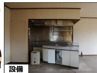
柱、内壁、床、天井
