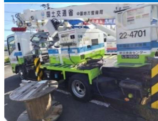
■照明車による電源支援
