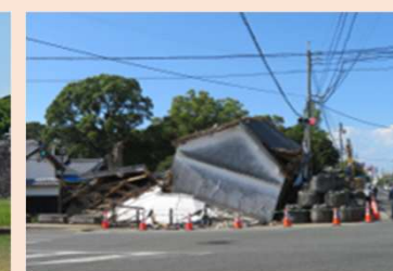
建造物の倒壊等 （八代市松浜軒）
