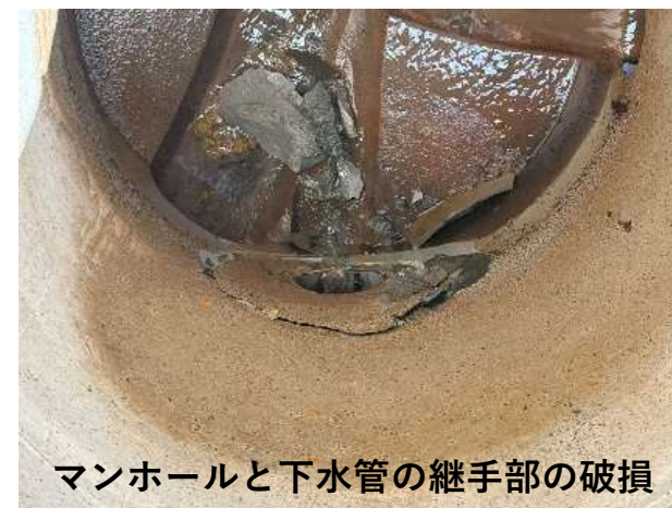
下水道の被害状況
