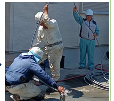
井戸の洗浄作業
