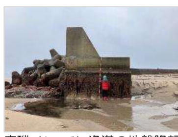
鹿磯（かいそ）漁港の地盤隆起
