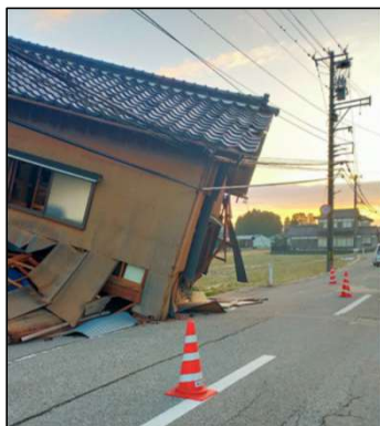
ケーブルの断線
