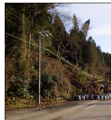
ケーブルの復旧
