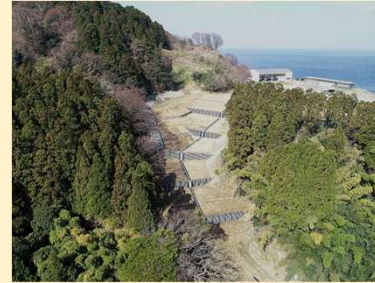
復旧した山腹崩壊現場
