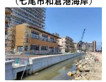
新たに製作した護岸の設置 (七尾市和倉港海岸)
