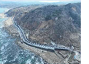
国道249号輪島市千枚田工区
