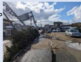
液状化被害（内灘市街地）
