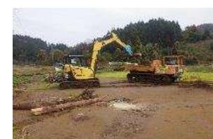
農地の堆積土砂・流木の撤去
