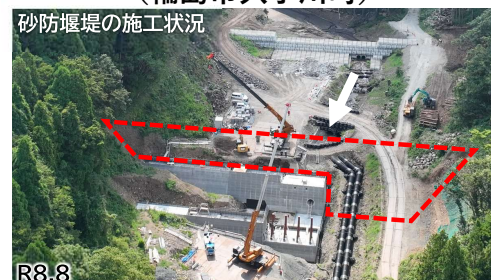
塚田川 恒久対策の施工 (輪島市久手川町)
