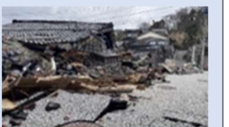
旧角海家住宅（重要文化財）
