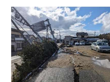
液状化被害(内灘市街地)
