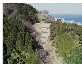
復旧した山腹崩壊現場
