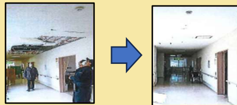
【介護施設の復旧の様子】
