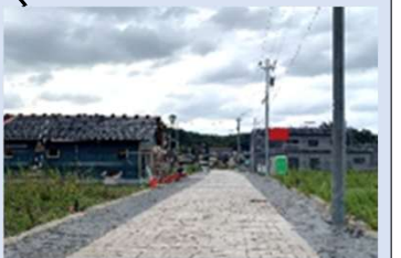
輪島朝市周辺エリアでの工事
