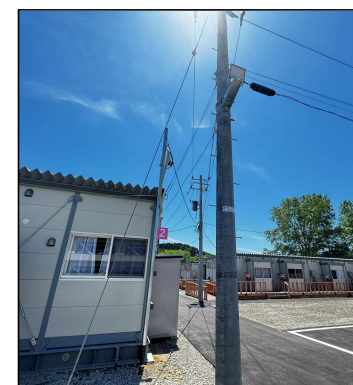
仮設住宅への整備
