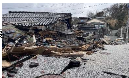
【旧角海家住宅(重要文化財)】
