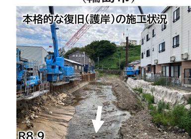
塚田川 護岸の本格的な復旧 (輪島市)
