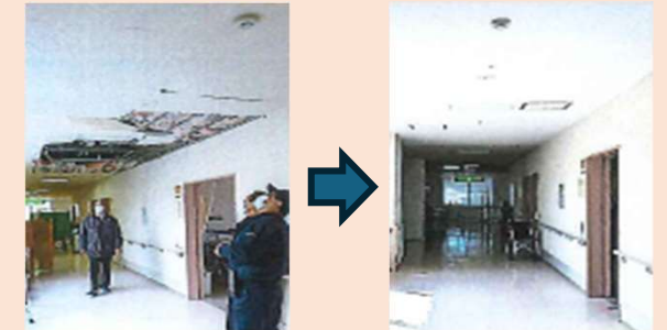
介護施設の復旧の様子
