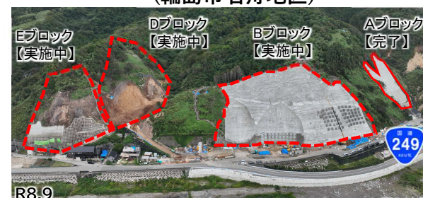
地すべり 恒久対策の施工 (輪島市名舟地区)
