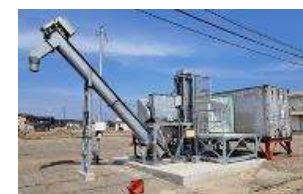
修復した砕氷貯氷施設
