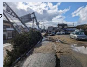
液状化被害（内灘市街地）
