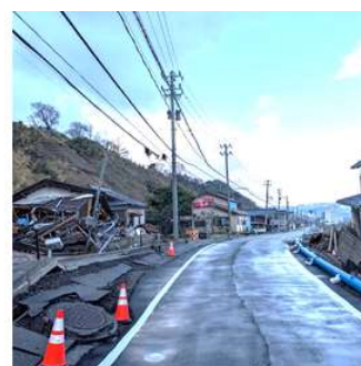
地震からの復旧
