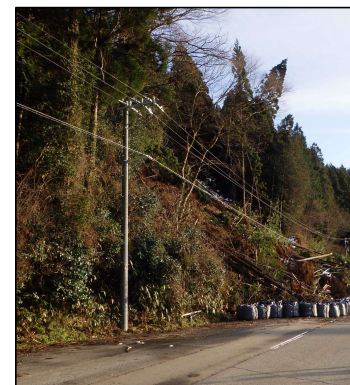
ケーブルの復旧
