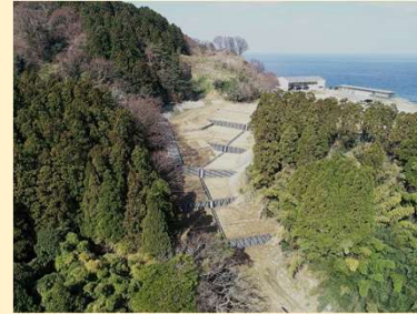
復旧した山腹崩壊現場
