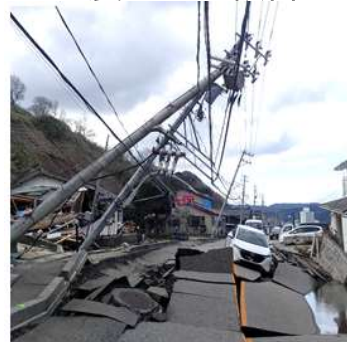
地震による被害
