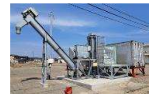
修復した砕氷貯氷施設
