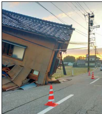
ケーブルの断線
