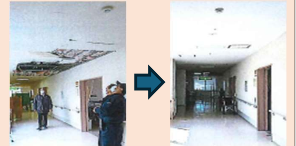
介護施設の復旧の様子
