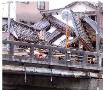
石川県穴水町 民家の被害
