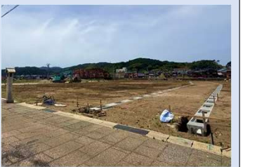
輪島朝市周辺エリアでの工事
