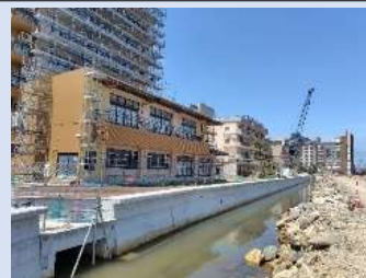
新たに製作した護岸の設置（和倉港海岸）
