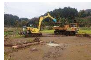
農地の堆積土砂・流木の撤去
