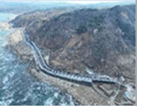
国道249号輪島市千枚田工区
