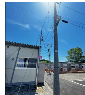
仮設住宅への整備
