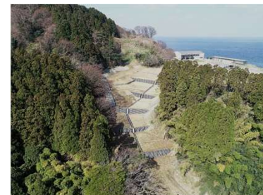
復旧した山腹崩壊現場
