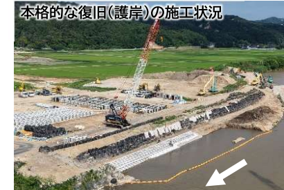
町野川 護岸の本格的な復旧 (輪島市)
