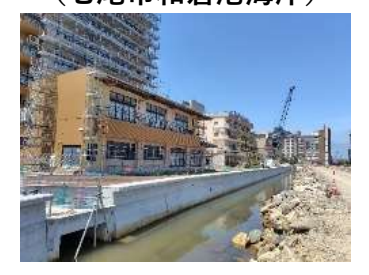
新たに製作した護岸の設置 (七尾市和倉港海岸)
