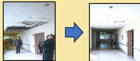
【介護施設の復旧の様子】
