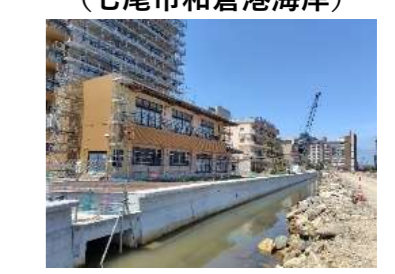
新たに製作した護岸の設置 (七尾市和倉港海岸)
