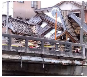
石川県穴水町 民家の被害
