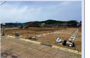
輪島朝市周辺エリアでの工事
