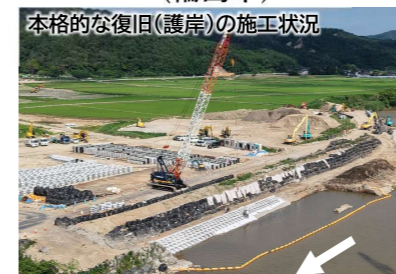
町野川 護岸の本格的な復旧 (輪島市)
