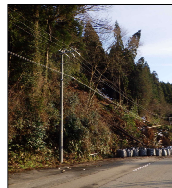
ケーブルの復旧
