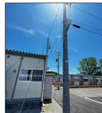
仮設住宅への整備
