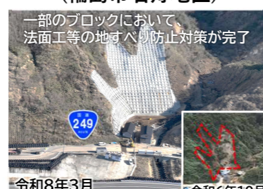
地すべり 恒久対策の施工 (輪島市名舟地区)
