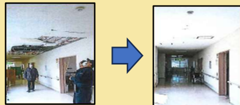
【介護施設の復旧の様子】
