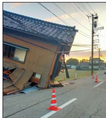
ケーブルの断線
