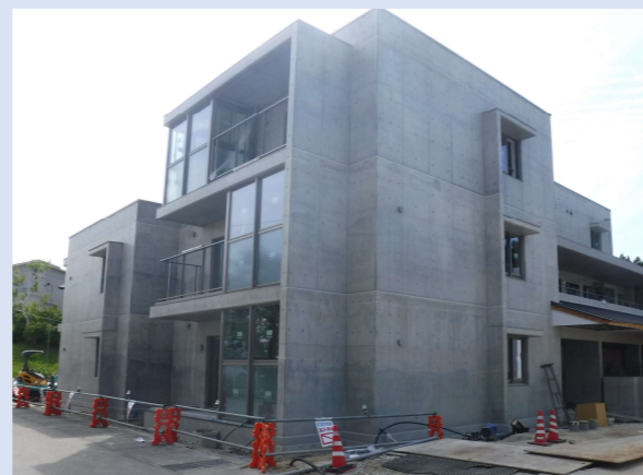
七尾市・小丸山団地で建設中の災害公営住宅
