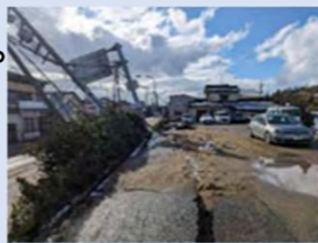
液状化被害(内灘市街地)
