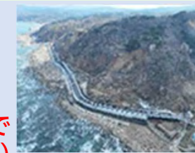
国道249号輪島市千枚田工区
