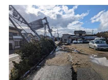
液状化被害 (内灘市街地)
