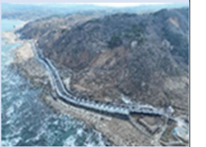
国道249号輪島市千枚田工区
