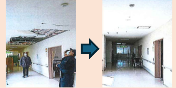
介護施設の復旧の様子
