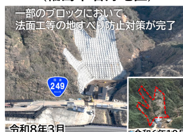
地すべり 恒久対策の施工 （輪島市名舟地区）
