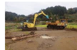
農地の堆積土砂・流木の撤去
