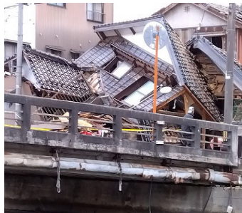
石川県穴水町 民家の被害
