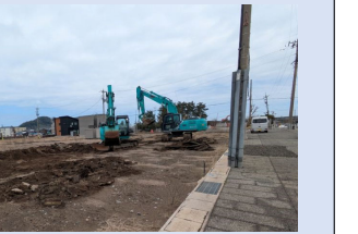
輪島朝市周辺エリアでの工事
