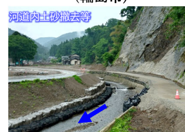
塚田川 応急安全対策完了 （輪島市）
