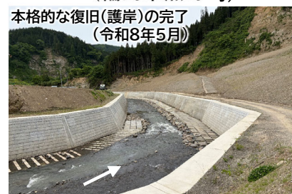
河原田川 護岸の本格的な復旧 （輪島市熊野町）
