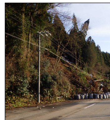
ケーブルの復旧
