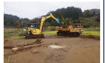
農地の堆積土砂・流木の撤去
