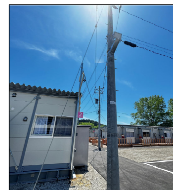
仮設住宅への整備
