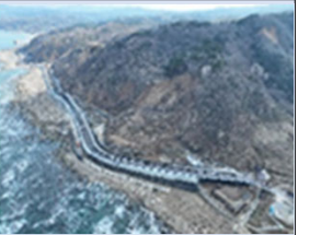
国道249号輪島市千枚田工区
