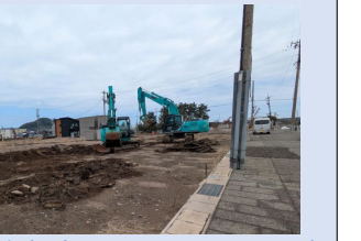
輪島朝市周辺エリアでの工事
