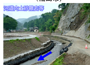
塚田川 応急安全対策完了 （輪島市）
