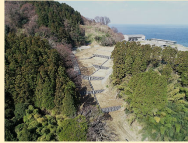
復旧した山腹崩壊現場
