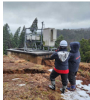
基地局の損壊
