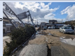
液状化被害 (内灘市街地)
