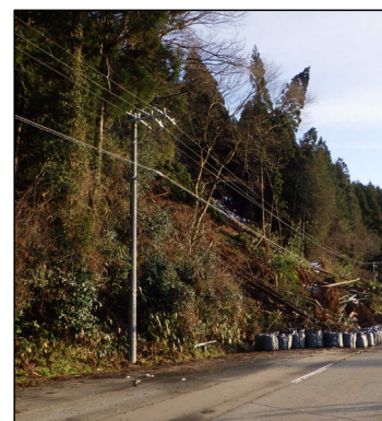
ケーブルの復旧
