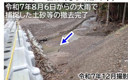
塚田川 仮設堰堤に堆積した土砂の撤去完了 （輪島市）
