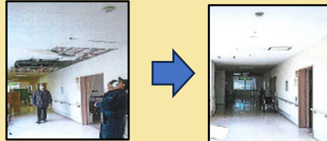
【介護施設の復旧の様子】
