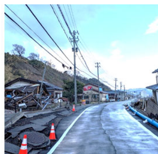
地震からの復旧
