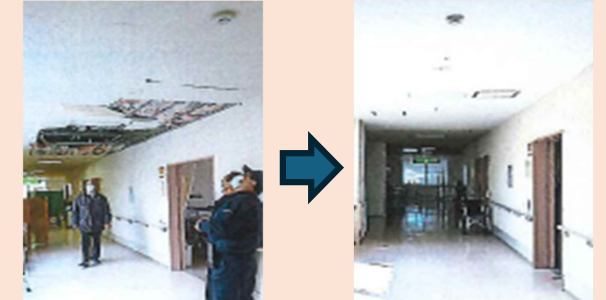
介護施設の復旧の様子
