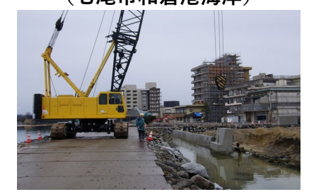
新たに製作した護岸の設置（七尾市和倉港海岸）
