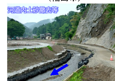
塚田川 応急安全対策完了（輪島市）
