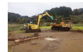
農地の堆積土砂・流木の撤去
