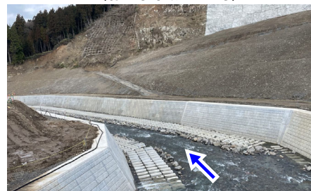
河原田川 護岸の本格的な復旧（輪島市熊野町）
