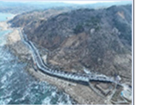
国道249号輪島市千枚田工区
