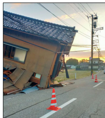
ケーブルの断線
