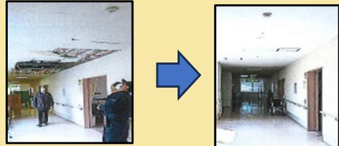
【介護施設の復旧の様子】
