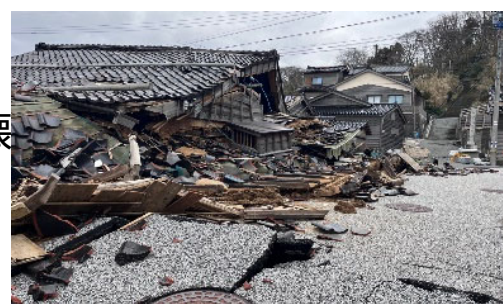
【旧角海家住宅(重要文化財)】
