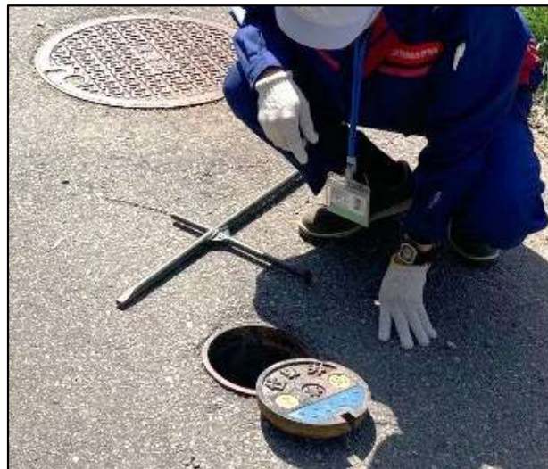
止水栓被災状況調査
