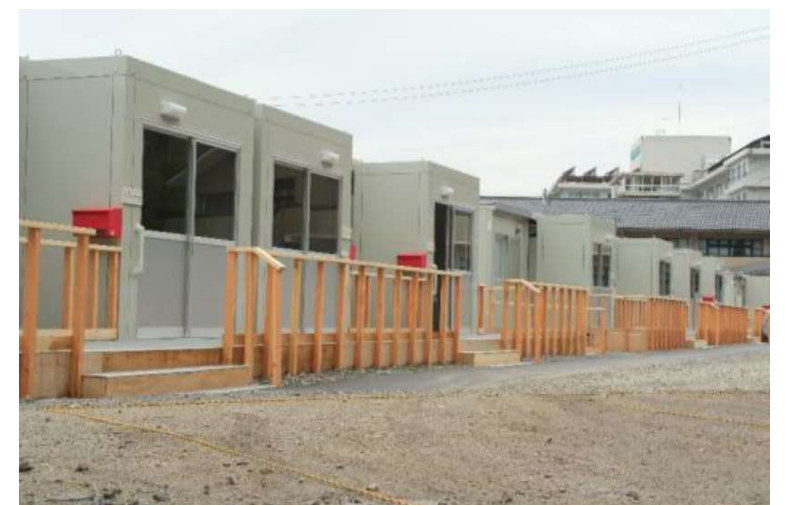
町内の仮設住宅
