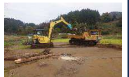
農地の堆積土砂・流木の撤去
