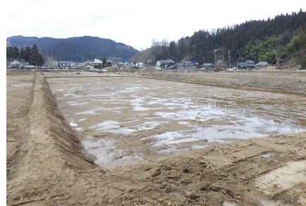
農地土砂撤去完了
