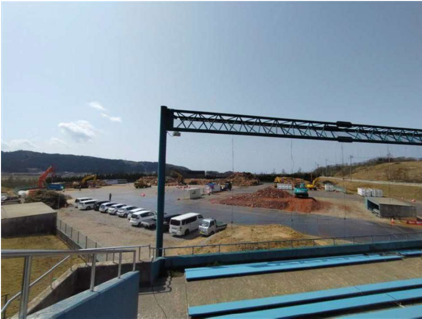
富来野球場仮置場
