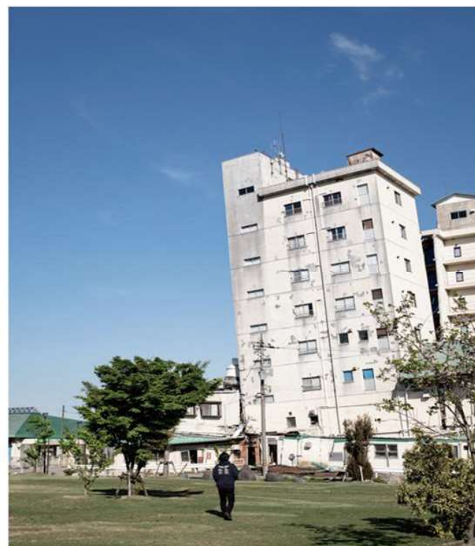
海側に大きく傾いた宿泊施設
