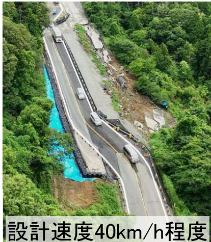
能越道での段階的な復旧イメージ
