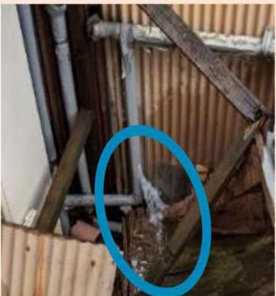
保温材が巻かれていない 露出配管の漏水
