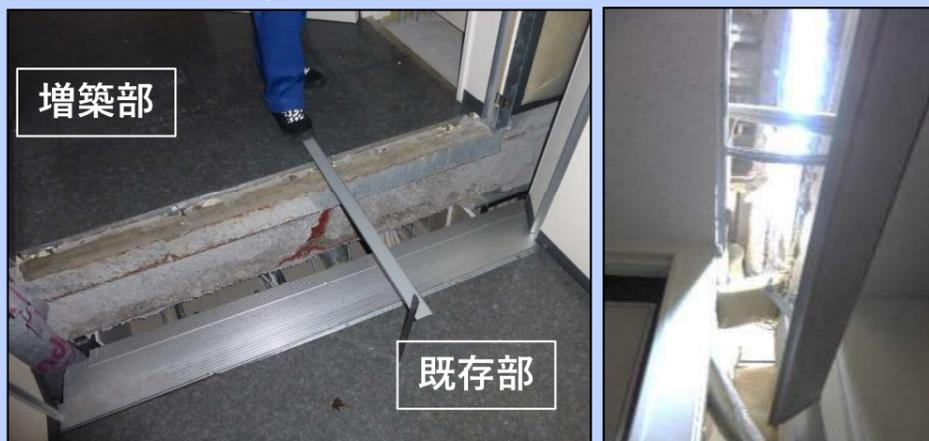
既存棟・増築棟間にずれが生じ、建物内部が屋外に露出
