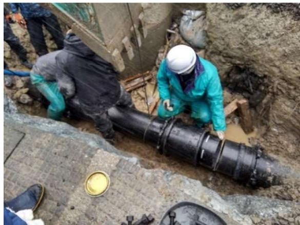
送水管損傷箇所の応急復旧
