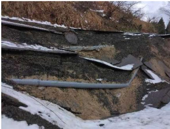
浄水場から配水池へ向かう水道管の破損・露出
