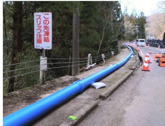
仮設配管による応急復旧
