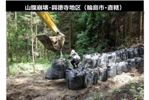
大型土のう設置（山腹崩壊の応急工事）
