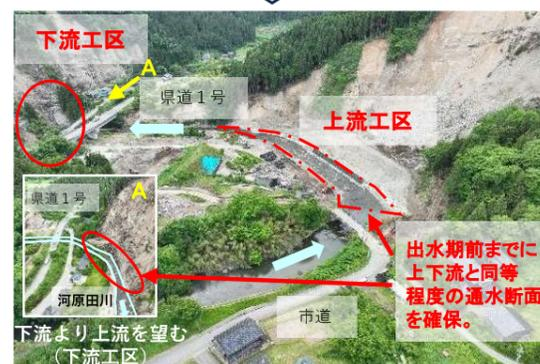
1月11日に河道閉塞箇所の工事に着手。出水期前までに上下流と同等程度の通水断面を確保。出水期明けに本復旧に着手予定。
