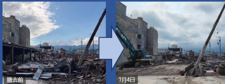
輪島朝市における解体・撤去工事
