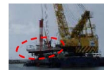
啓開作業の状況（2/27）
