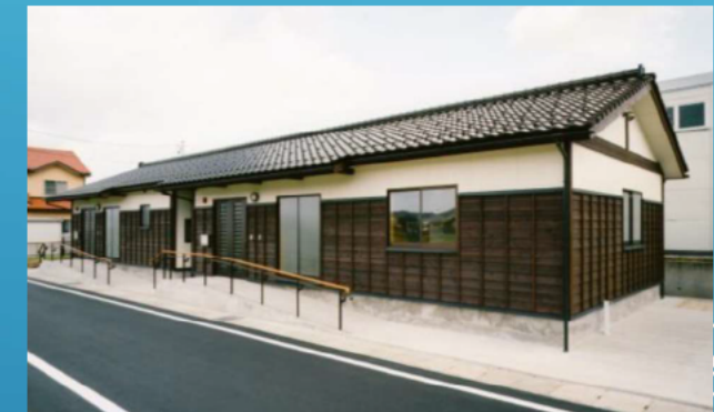
災害公営住宅(H19能登半島地震)
