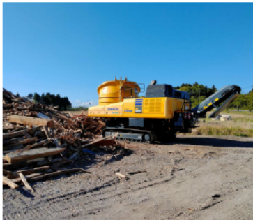
珠洲市ジャンボリー跡地仮置場： 移動式破砕機（稼働中）
