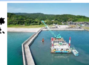
狼煙漁港における浚渫工事(珠洲市)
