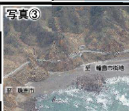
写真③ 国道249号輪島市町野町大川～浜田町 (大川浜工区) ■R6年内に1車線通行確保予定
