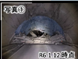
写真① なかや 国道249号中屋トンネル (中屋トンネル工区) ■9月末までに1車線通行確保予定 ■R6年内にトンネルの2車線通行確保予定
