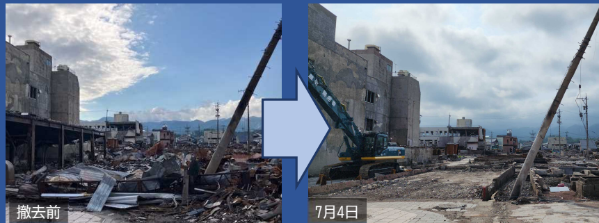
輪島朝市における解体・撤去工事
