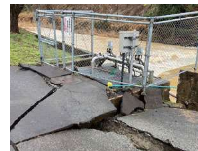
水道の復旧 (被災した浄水場)
