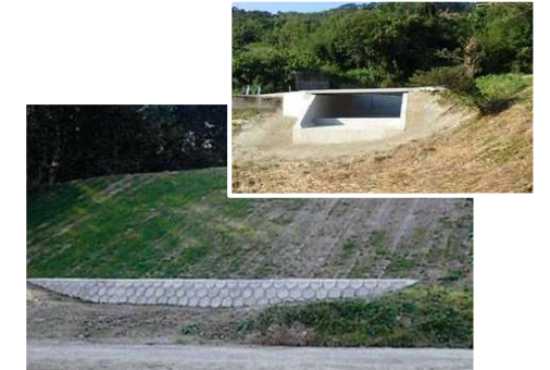
ため池の堤体復旧と併せ行う 未被災の洪水吐きの拡幅
