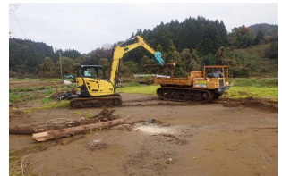
農地の堆積土砂・流木の撤去
