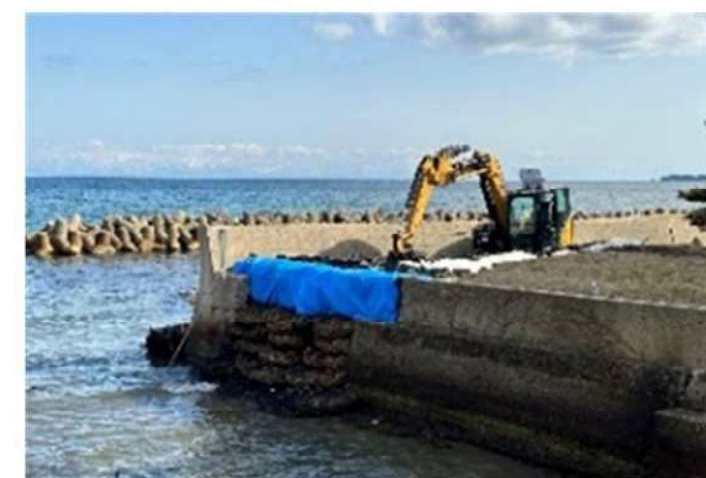
袋詰玉石、大型土のう敷設完了
