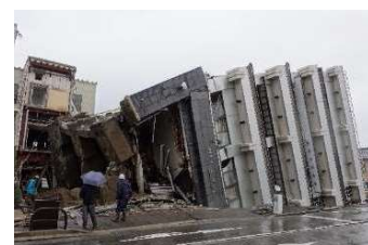
建築物の転倒被害
