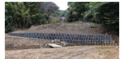
応急対策完了（大型土のう設置）（珠洲市）
