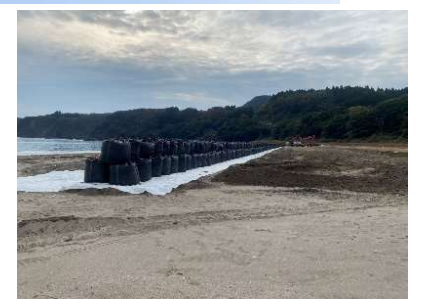
狼煙漁港における復旧工事（珠洲市,11月）
