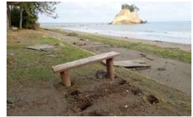
見附園地（珠洲市） 津波によりベンチ等が損壊
