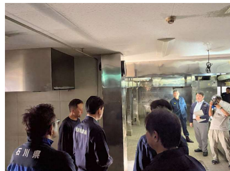
泥出し後の厨房
