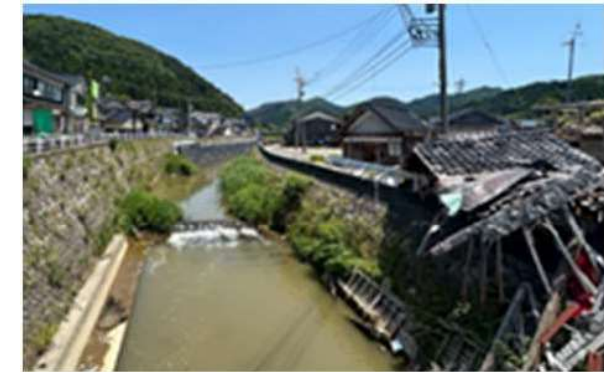
R6.1 地震による被災(R6.6時点)
