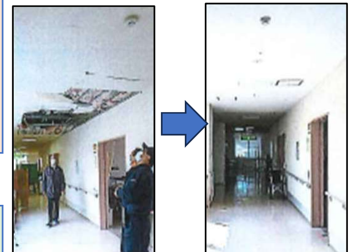
【介護施設の復旧の様子】
