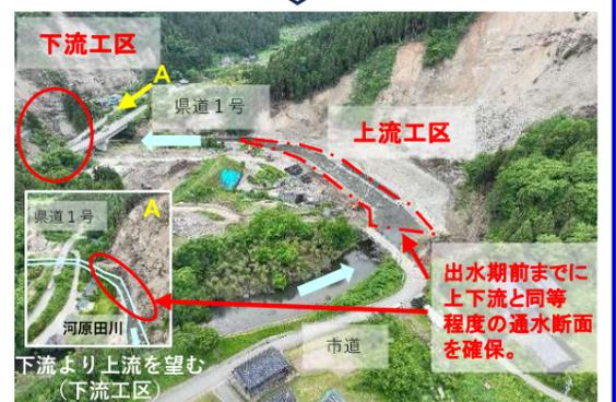
1月11日に河道閉塞箇所の工事に着手。出水期前までに上下流と同等程度の通水断面を確保。出水期明けに本復旧に着手予定。
