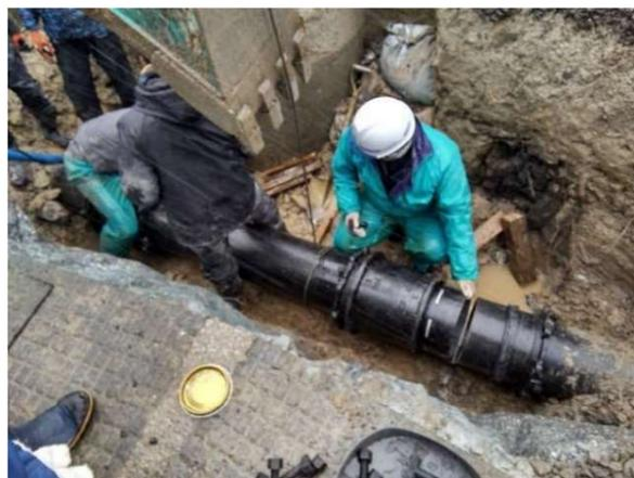
送水管損傷箇所の応急復旧
