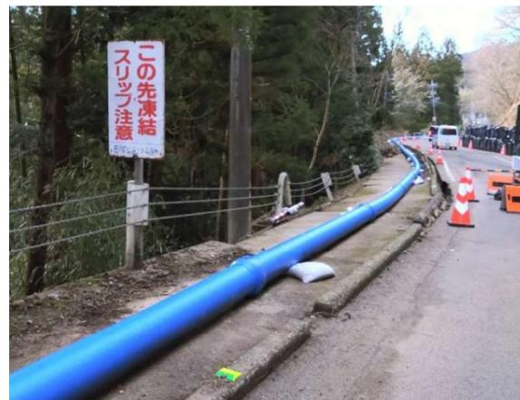
仮設配管による応急復旧
