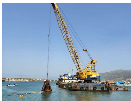
小型船だまりの浚渫作業の状況(4/19) 移動が完了した漁船(4/23)
