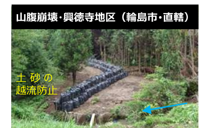
大型土のう設置
