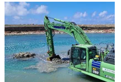
赤神漁港の仮復旧工事（輪島市,8月）
