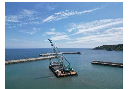
狼煙漁港における浚渫工事（珠洲市,8月）
