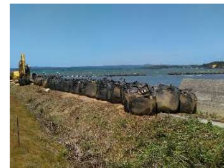
大型土のう設置（農地海岸）（七尾市）
