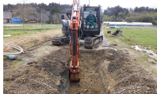
＜パイプライン修繕工事（能登町）＞
