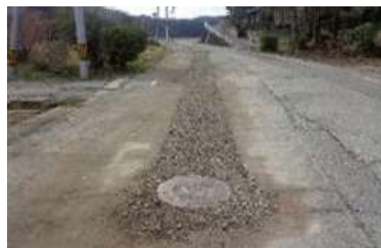
＜農業集落排水施設における管路の仮復旧（能登町）＞
