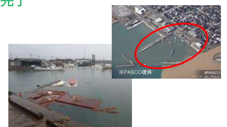
船だまりの被害状況
