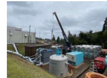
可搬式浄水装置の設置（珠洲市）
