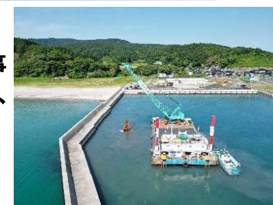
狼煙漁港における浚渫工事(珠洲市、6月)
