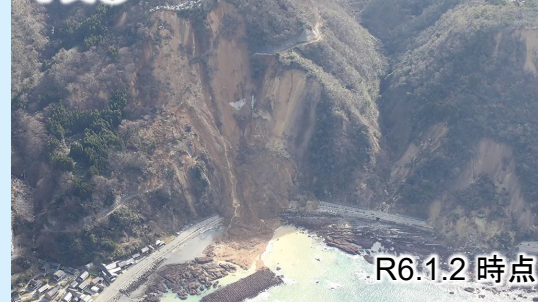
写真③ 国道249号法面崩落
