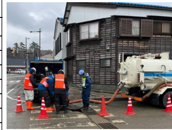
輪島市 バキューム車により下水処理場へ運搬
