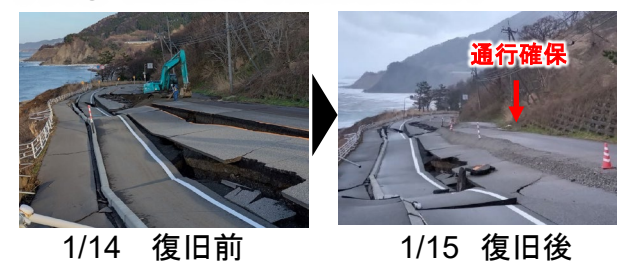
写真② 国道249号緊急復旧完了
