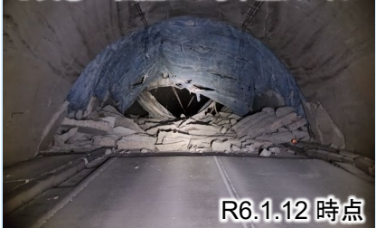
写真① 国道249号中屋トンネル
