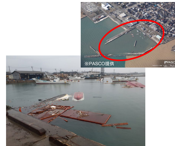
船だまりの被害状況
