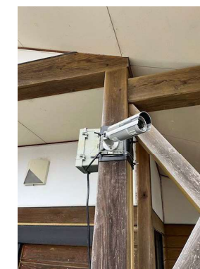
防犯カメラの設置
