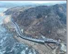
国道249号輪島市千枚田工区
