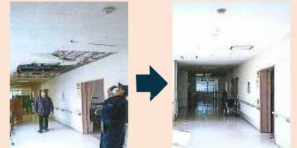
介護施設の復旧の様子
