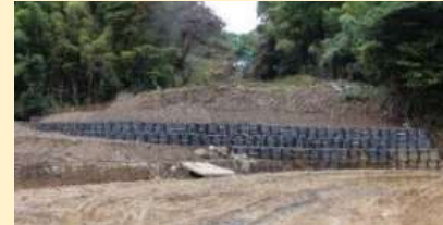
山腹崩壊の応急対策完了 （大型土のう設置）
