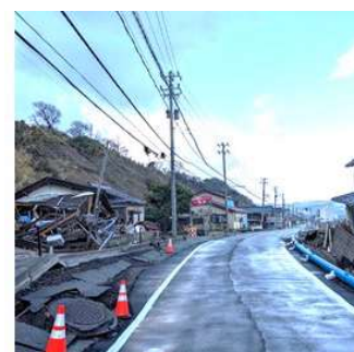
地震からの復旧
