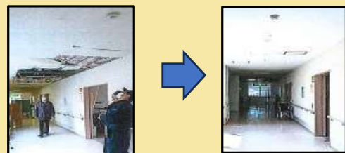
【介護施設の復旧の様子】
