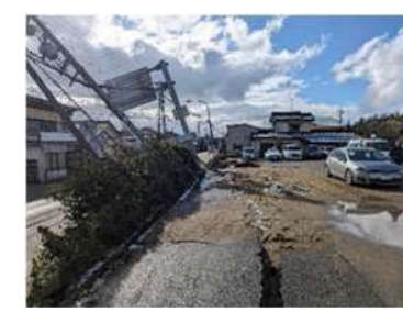
液状化被害(内灘市街地)
