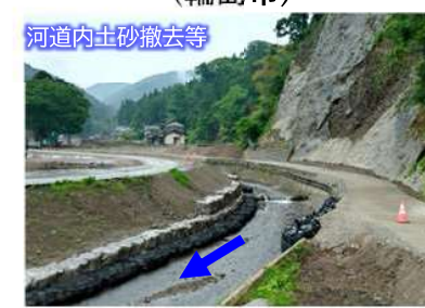
塚田川 応急安全対策完了(輪島市)
