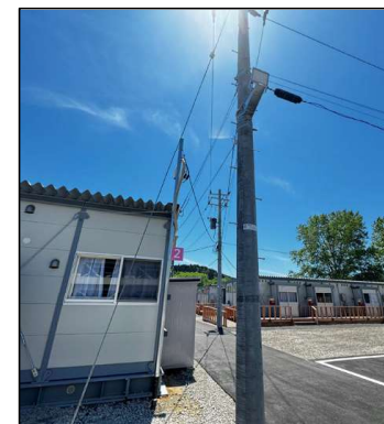
仮設住宅への整備
