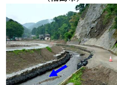
塚田川 河道内土砂撤去等（輪島市）
