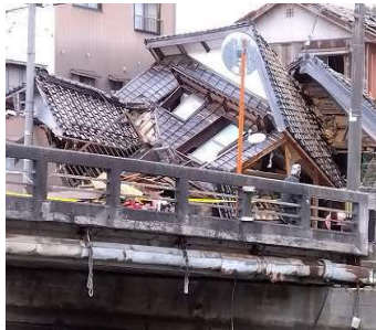
石川県穴水町 民家の被害
