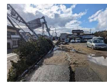
液状化被害（内灘市街地）
