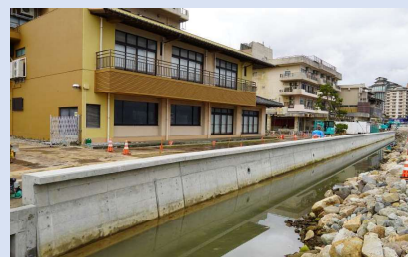
新たに製作した護岸の設置（和倉港海岸）
