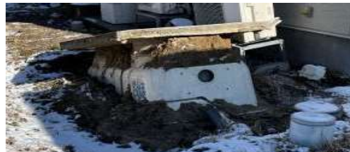
地震により浮き上がった浄化槽(画像は七尾市内の例)
