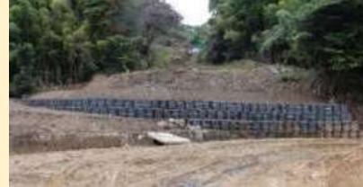
山腹崩壊の応急対策完了 （大型土のう設置）
