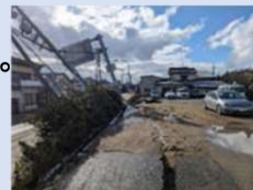
液状化被害（内灘市街地）
