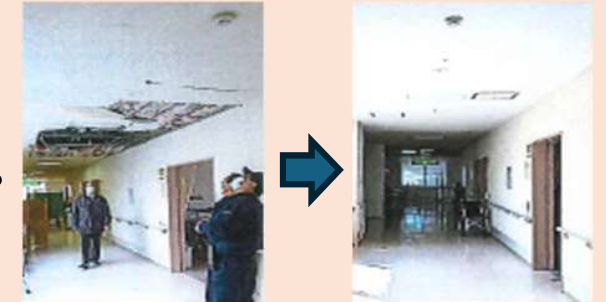
介護施設の復旧の様子
