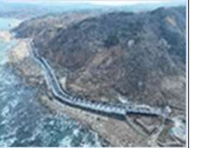
国道249号輪島市千枚田工区
