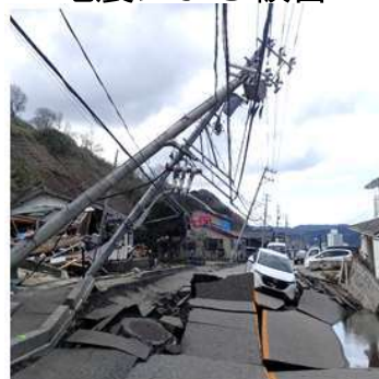
地震による被害
