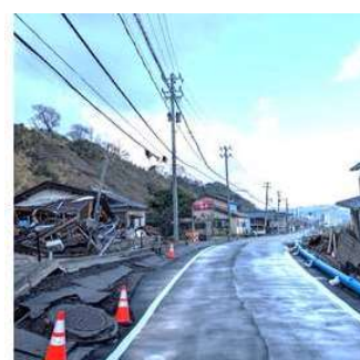
地震からの復旧
