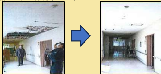
【介護施設の復旧の様子】
