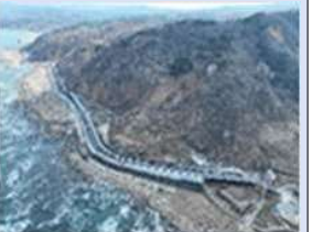
国道249号輪島市千枚田工区
