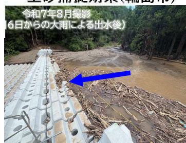
塚田川 仮設堰堤による 土砂捕捉効果（輪島市）
