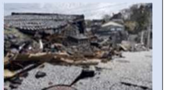
旧角海家住宅（重要文化財）
