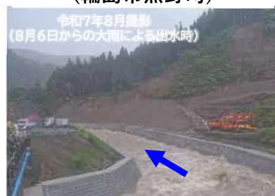
河原田川 洪水の流下状況 （輪島市熊野町）
