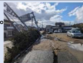
液状化被害（内灘市街地）
