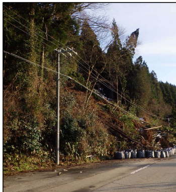
ケーブルの復旧
