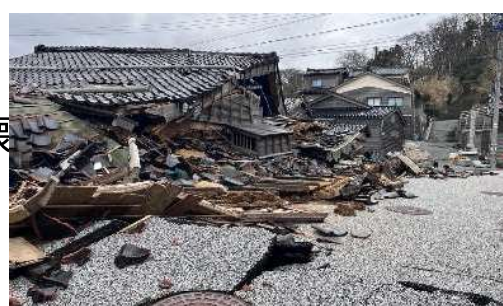
【旧角海家住宅(重要文化財)】
