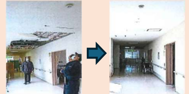
介護施設の復旧の様子
