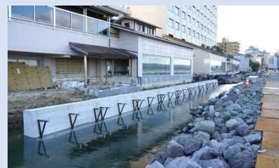
新たに製作した護岸の設置（和倉港海岸）
