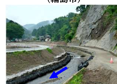
塚田川 河道内土砂撤去等 （輪島市）
