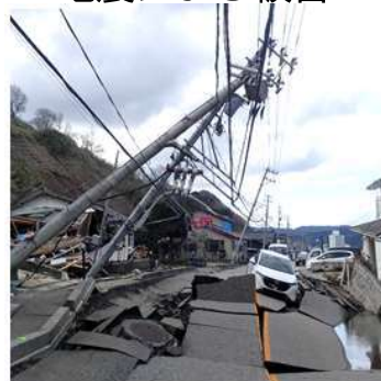
地震による被害
