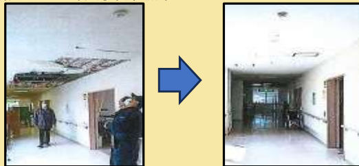
【介護施設の復旧の様子】
