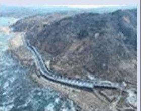
国道249号輪島市千枚田工区
