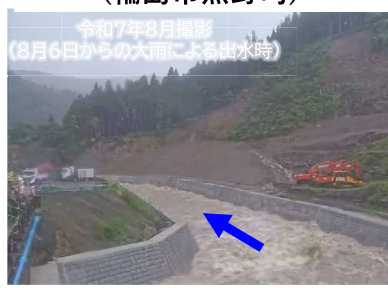
河原田川 洪水の流下状況 （輪島市熊野町）
