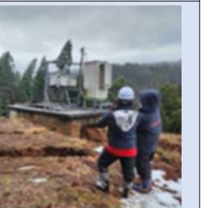
通信基地局の損壊
