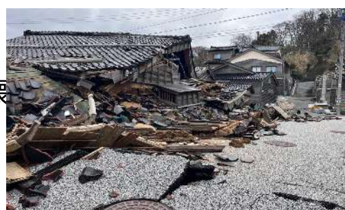
【旧角海家住宅(重要文化財)】
