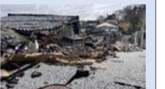
旧角海家住宅（重要文化財）
