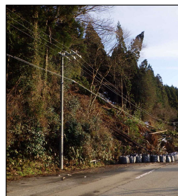
ケーブルの復旧
