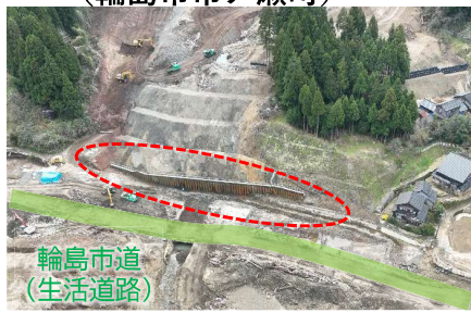
河原田川 法止工の施工 （輪島市市ノ瀬町）
