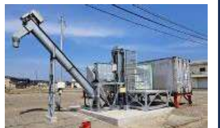
修復した砕氷貯氷施設
