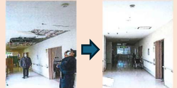
介護施設の復旧の様子
