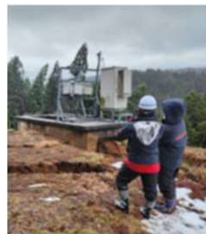
基地局の損壊
