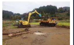
農地の堆積土砂・流木の撤去
