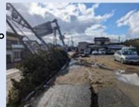
液状化被害（内灘市街地）
