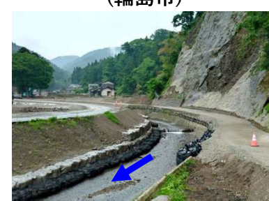
塚田川 河道内土砂撤去等 （輪島市）
