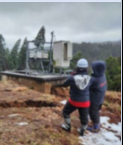
通信基地局の損壊
