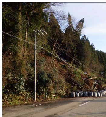
ケーブルの復旧
