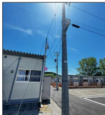
仮設住宅への整備
