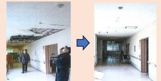
介護施設の復旧の様子
