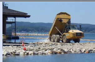
護岸復旧のための仮設道路整備(和倉港)
