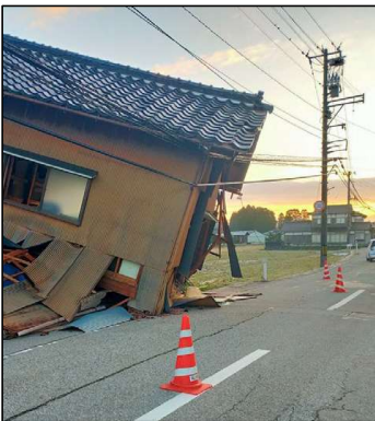
ケーブルの断線
