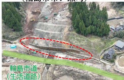
河原田川 法止工の施工 （輪島市市ノ瀬町）
