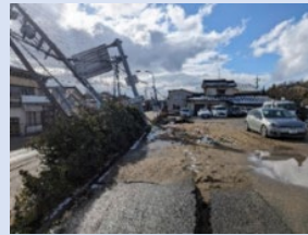
液状化被害(内灘市街地)
