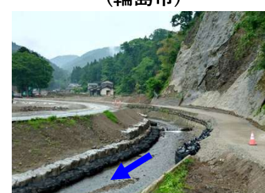
塚田川 河道内土砂撤去等 （輪島市）
