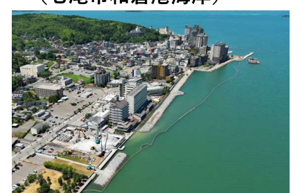
護岸復旧の仮設道路整備 （七尾市和倉港海岸）
