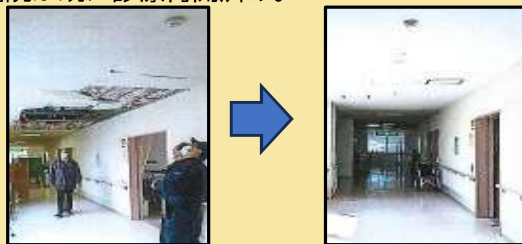
【介護施設の復旧の様子】
