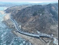
国道249号輪島市 千枚田工区
