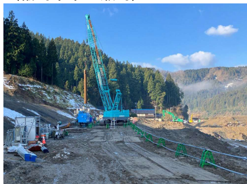
河原田川 法止工の施工 （輪島市市ノ瀬町）
