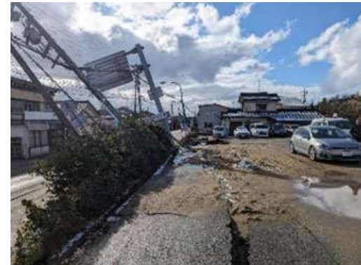
液状化被害 （内灘市街地）
