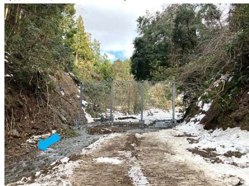
塚田川 ワイヤーネットの設置 （輪島市久手川町）
