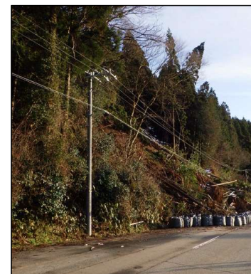
ケーブルの復旧
