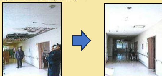
【介護施設の復旧の様子】
