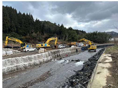
豪雨で被災河川護岸の応急復旧 （輪島市塚田川）
