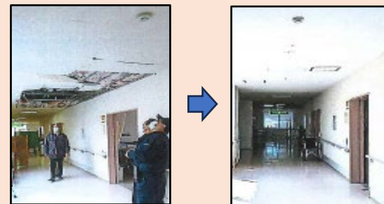
介護施設の復旧の様子
