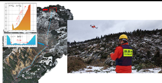
▲山腹崩壊箇所及び周辺環境の状況把握
