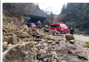
▲道路損壊により、 狭隘化した道路を通過 する普通車クラスの消防車
