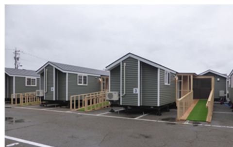
▲トレーラーハウスの設置事例(石川県滋賀町)
