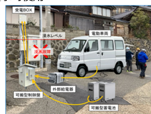
▲志賀町設置例(地震後に設置)
