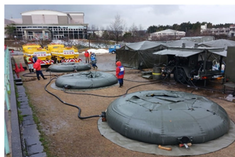
▲ 仮設風呂への給水活動
