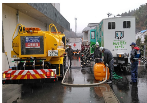
▲ トレーラートイレへの給水活動
