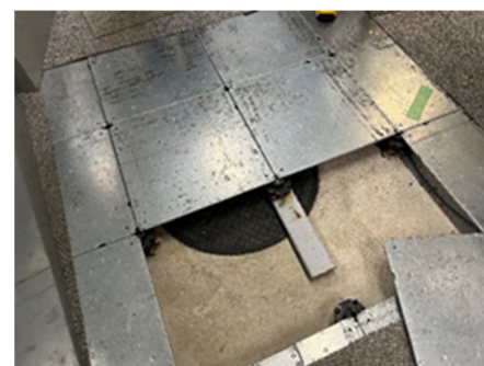
▲建物地下に設置された雨水貯留槽
