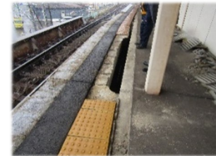
【被災した鉄道施設】
