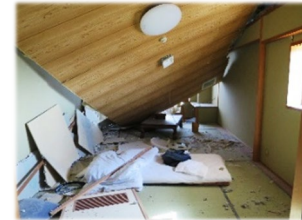
【被災した旅館客室内】
