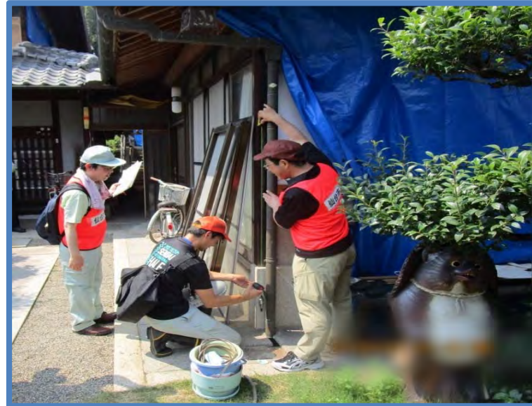
建物被害認定調査 (岡山県総社市)
