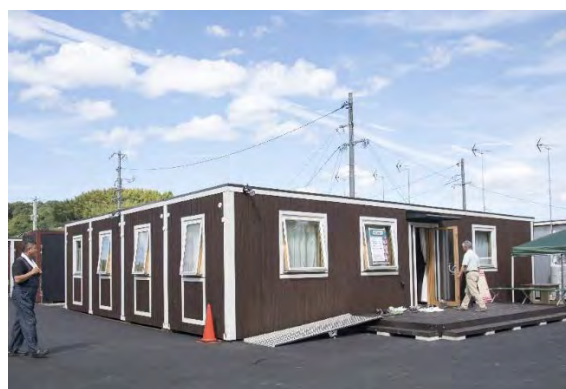
トレーラーハウス仮設住宅
