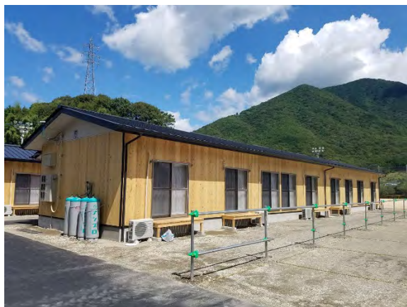
木造仮設住宅
