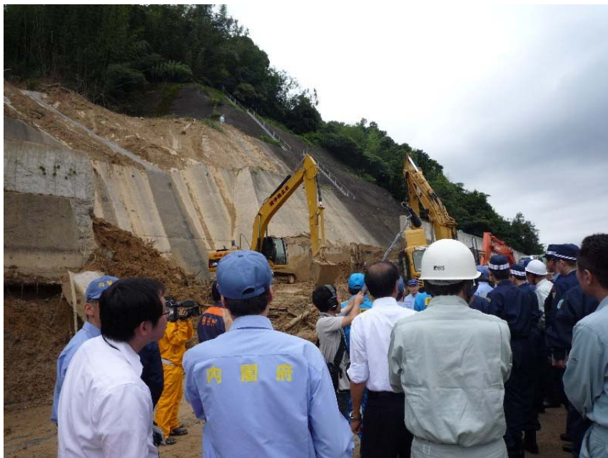
土砂崩れ現場
