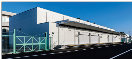
上：庁舎 下：備蓄倉庫棟
