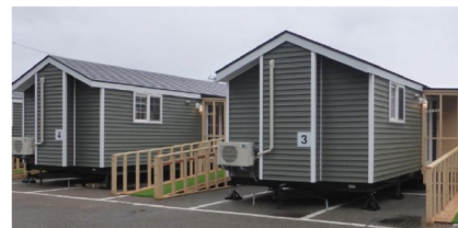
トレーラーハウス
