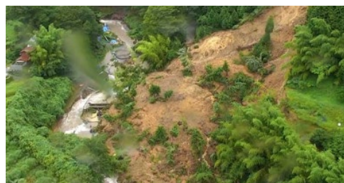
R5.6.29からの大雨による 土砂災害発生状況(大分県由布市)
