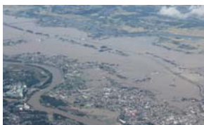
水害による被害例
