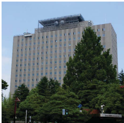
仙台第1地方合同庁舎（増築棟）
