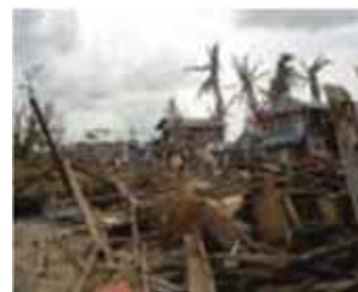
サイクロン「ナルギス」の被害を受けた住宅 (ミャンマー)
