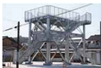
津波避難施設の整備
