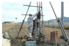
ボーリング調査
