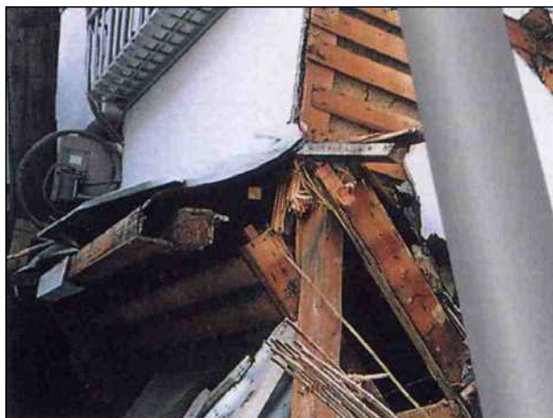
柱、梁の割れ、断面欠損が著しい。
