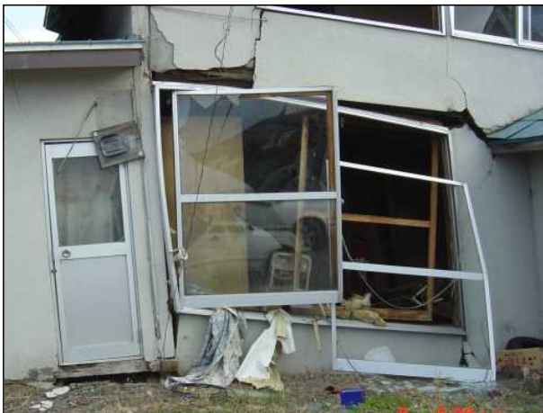
【アルミサッシ】 枠ごとはずれて破壊されている。
