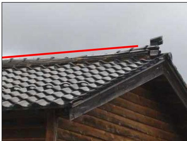
1504 棟瓦のずれ、破損、落下が著しいが、その他の瓦の破損は少ない。
