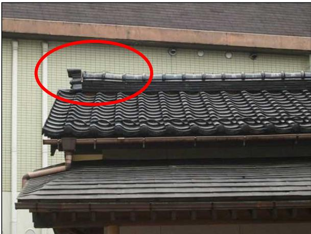
1501 棟瓦(がんぶり瓦、のし瓦)の一部がずれ、破損が生じている。
