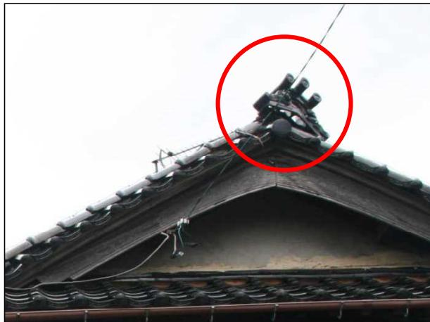
1502 棟瓦(がんぶり瓦、のし瓦)の一部がずれ、破損が生じている。
