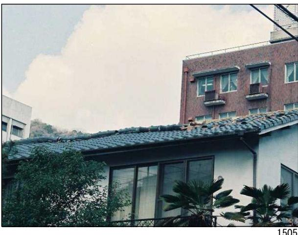
1505 棟瓦が全面的にずれ、破損あるいは落下している。
