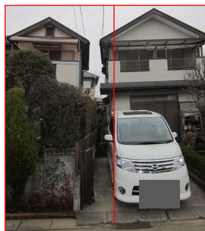
敷地も含めた傾斜が見られる。 40000
