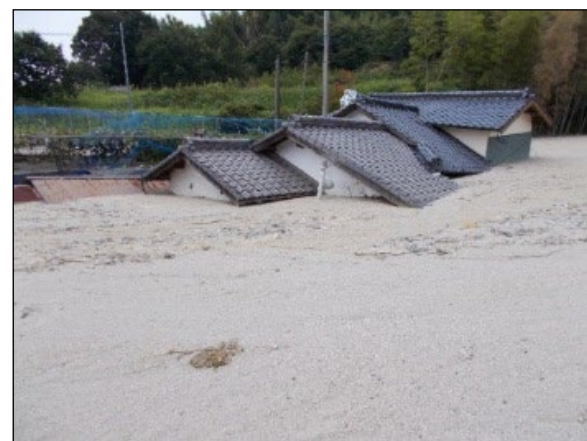
土砂等が住家及びその周辺に一樣に堆積している。
