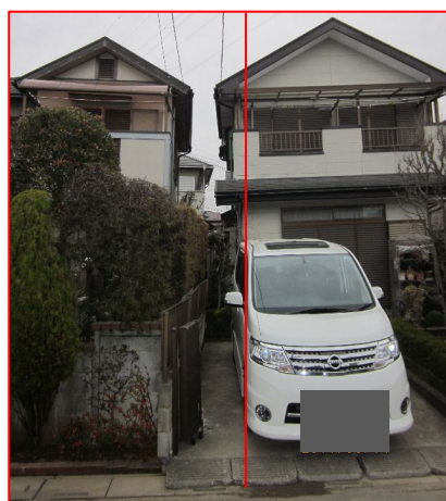
敷地も含めた傾斜が見られる。 40000
