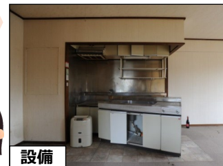
柱、内壁、床、天井
