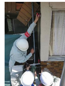
タブレットで傾斜測定の記録を行う様子
