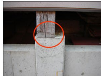
束が束石よりわずかにずれている。
