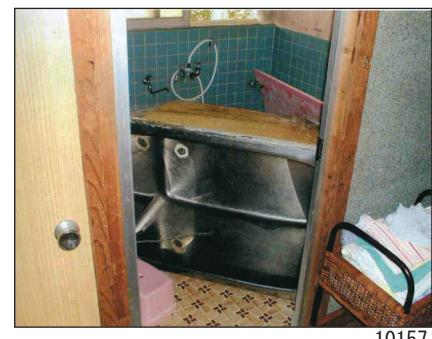
(浴槽：転倒し、配管が切れ再使用が不可能。 (3%) )
