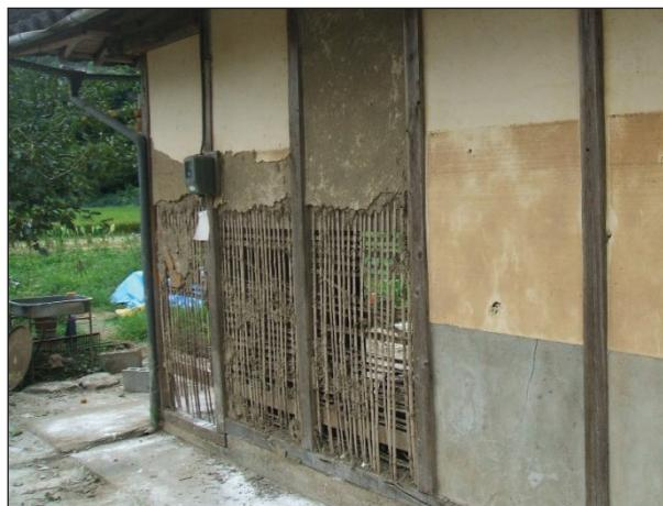
浸水により塗土の大半が剥離している。
