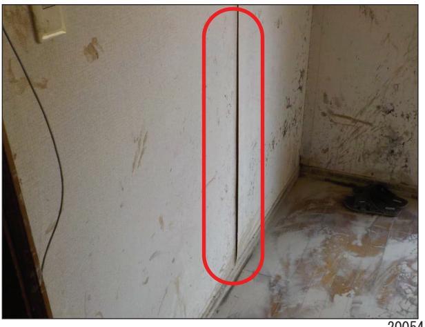
ボードの目地部にひび割れやすれが生じている。
