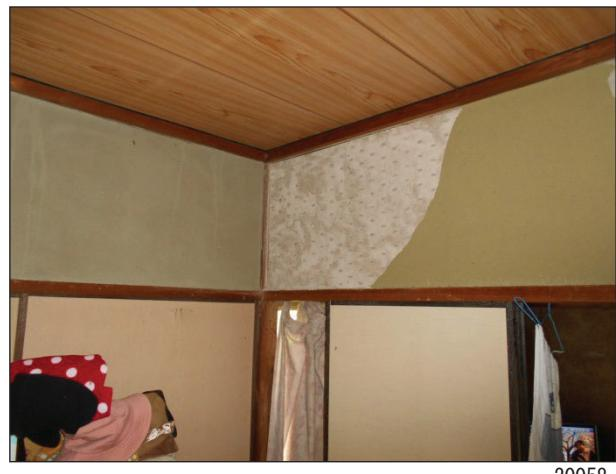
浸水により塗土の半分程度が剥落している。
