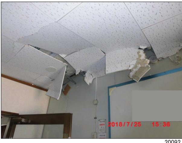
天井板が脱落している。
