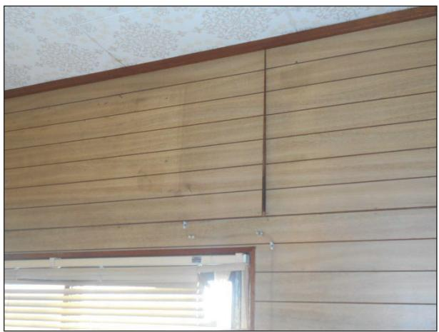
内壁合板にずれが生じている。
