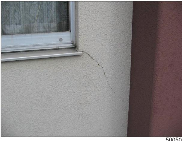
近寄らないと見えにくい程度のひび割れ(幅約0.2mm以下)が生じている。
