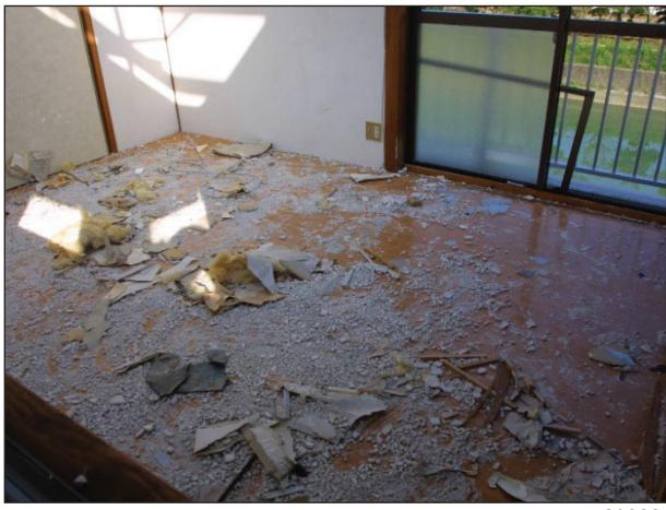
浸水により床板の汚損が見られる。
