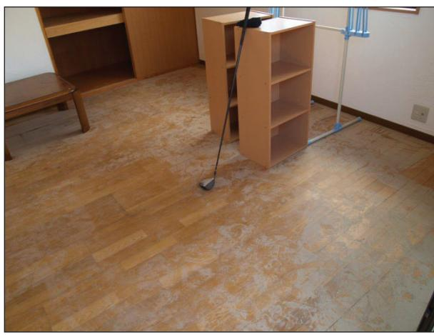
浸水により床材の汚損が見られる。
