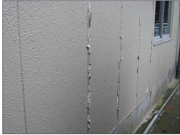
外壁の仕上材の隅角部等にわずかな亀裂が生じている。また、わずかな剥離、目地のずれが見られる。
