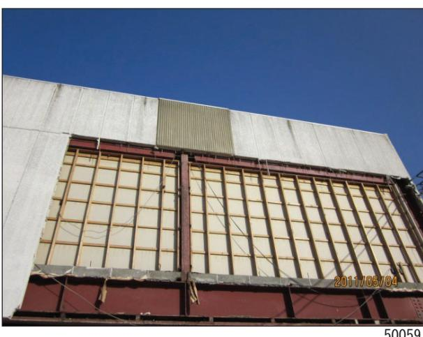
外壁の仕上材が大きく剥落している。
