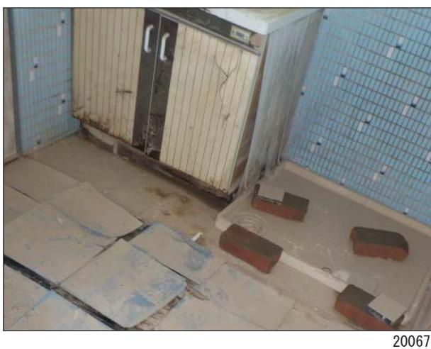
浸水により合成樹脂系床材の剥離が見られる。
