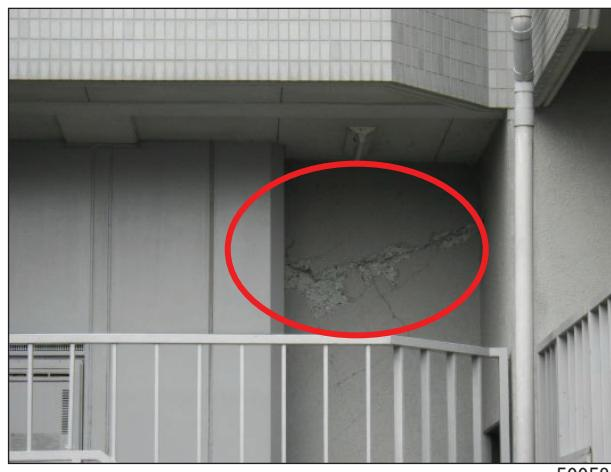
比較的大きなひび割れ(幅約1mm~2mm)が生じているが、コンクリートの剥落は極くわずかであり、鉄筋は露出していない。
