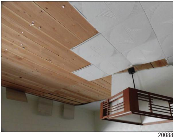
浸水による天井仕上(クロス等)の剥離・表面劣化が見られる。
