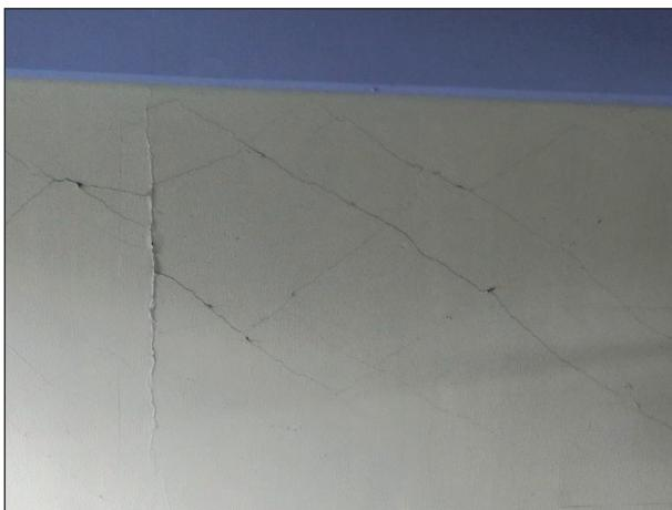
肉眼ではっきりと見える程度のひび割れ(幅約0.2mm~1mm)が生じているものの、コンクリートの剥落は生じていない。
