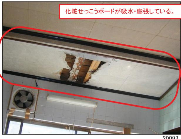
浸水による下地材・化粧せっこうボード・その他天井材の吸水・膨張・不陸等の機能損失が見られる。
