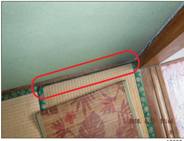
床と壁との間にわずかなずれが生じている。
