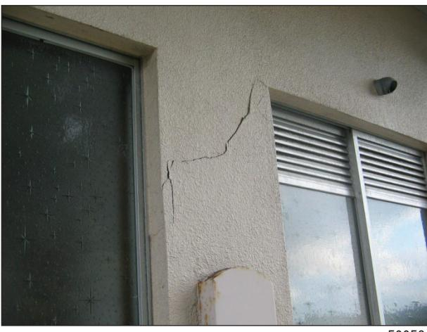
肉眼ではっきり見える程度のひび割れ(幅約0.2mm~1mm)が生じているものの、コンクリートの剥落は生じていない。
