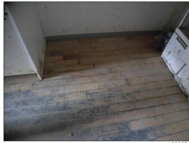
浸水により床板の汚損が見られる。
