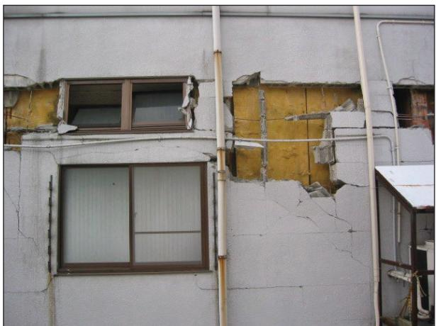
外壁の仕上材が部分的に剥落している。
