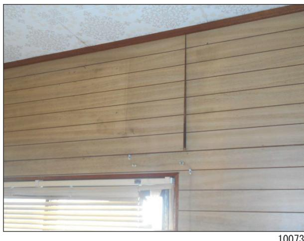
内壁合板にずれが生じている。
