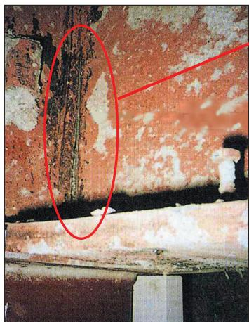
ウェブ溶接部の亀裂
