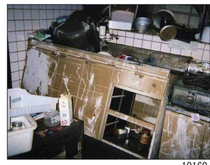
(台所の流し台：転倒し、配管が切れ、再使用は不可能。 (3%) )
