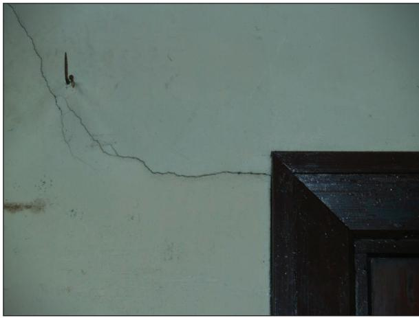
塗り壁隅部にわずかなひび割れが生じている。
