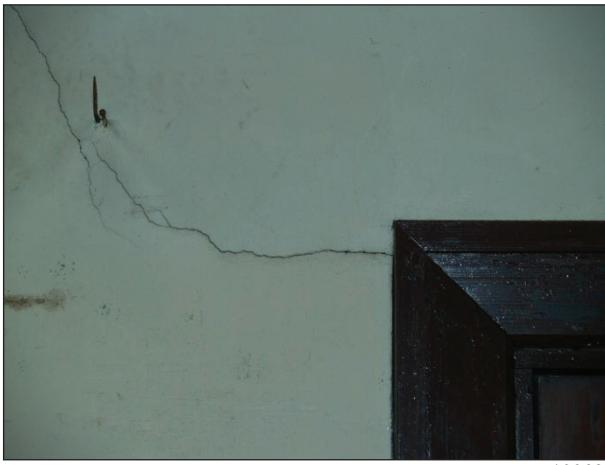
塗り壁隅角部にわずかなひび割れが生じている。
