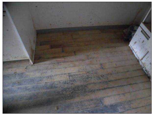
浸水により床材の汚損が見られる。
