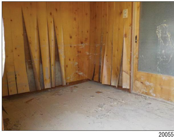
(浸水により仕上材の剥離等が見られる。)
