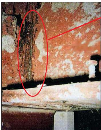
ウェブ溶接部の亀裂
