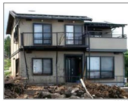
(ベランダ：手摺が破損している。)
