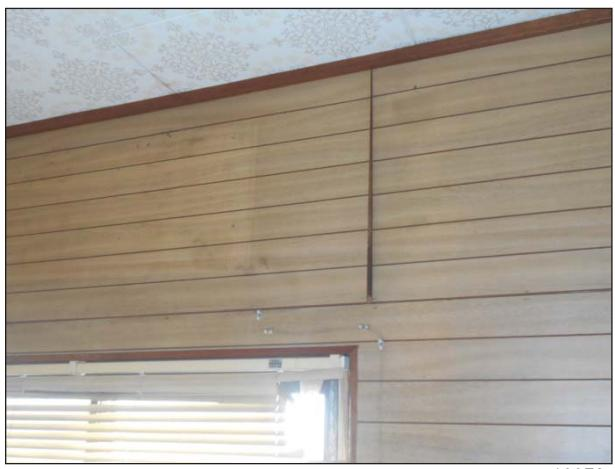
内壁合板にずれが生じている。
