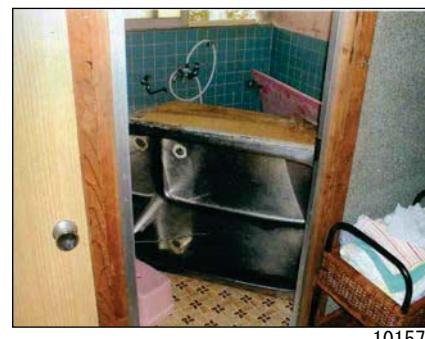
(浴槽：転倒し、配管が切れ再使用が不可能。
