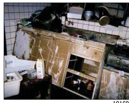
(台所の流し台：転倒し、配管が切れ、再使用は不可能。(3%) )
