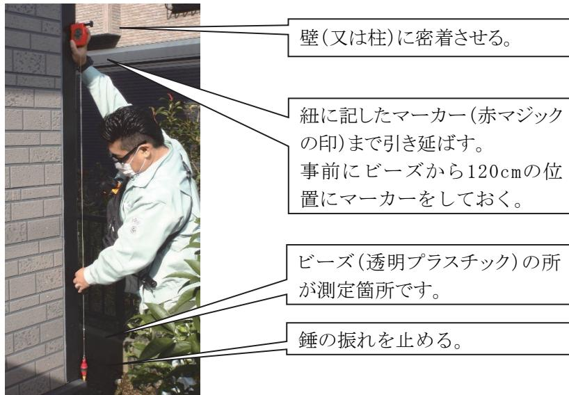
②壁（又は柱）との空き寸法を計測する。
