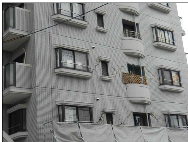
【外部仕上】 大きなひび割れ又は仕上の剥離が見られる。
