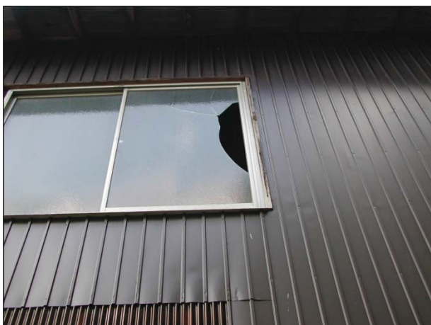
【アルミサッシ】 ガラスが破損している。
