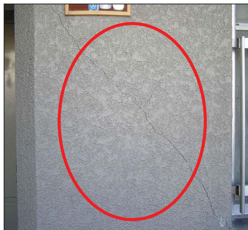
【雑壁】 一部にひび割れ(幅約0.2mm～1mm)やはがれが生じている。
