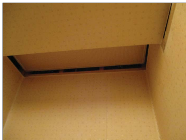
【天井】 天井板の浮きが生じている。
