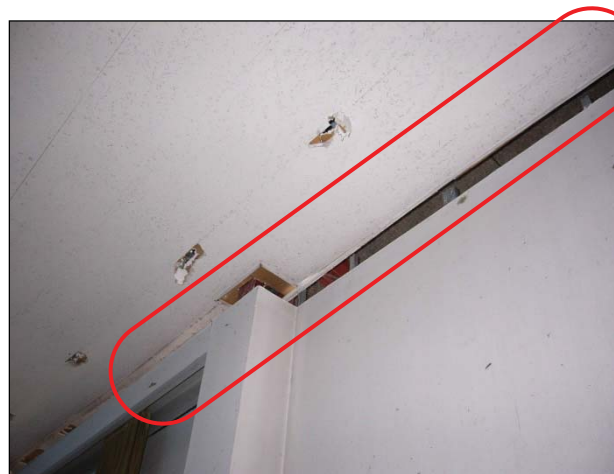
【天井】 天井板のずれが見られる。
