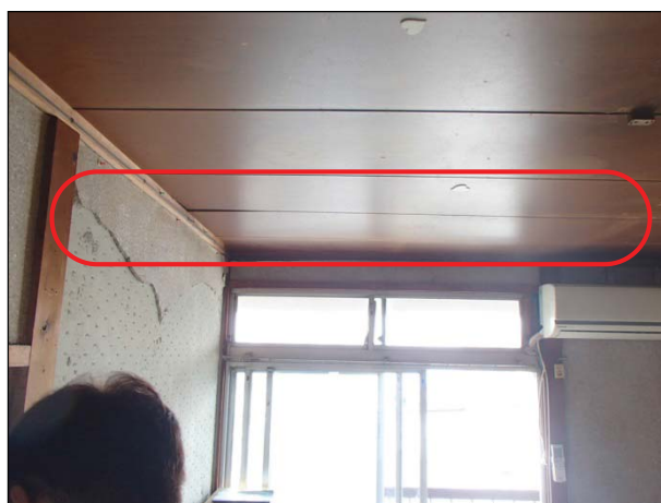
【天井】 天井板に隙間が生じている。
