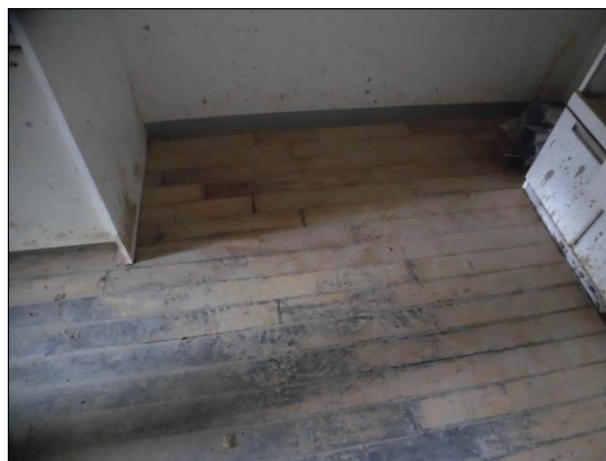
浸水により床材の汚損が見られる。
