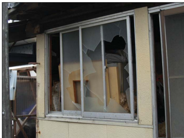
【アルミサッシ】 ガラスが破損している。
