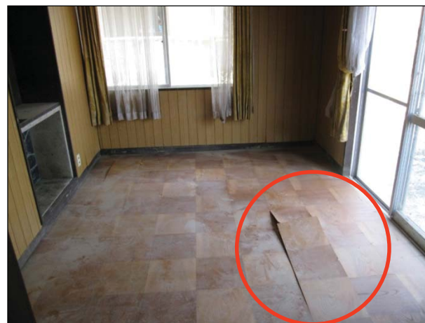
浸水によりフローリング材の層間剥離・浮き上がり、沈下が見られる。
