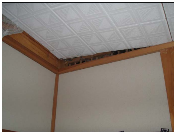
【天井】 天井板の浮きが生じている。
