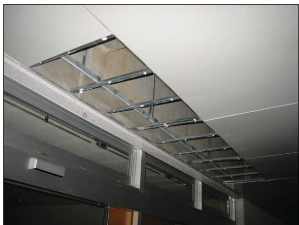
【天井】 天井板が脱落している。
