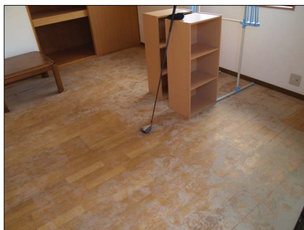
浸水により床材の汚損が見られる。
