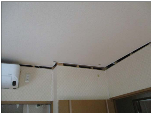
【天井】 天井板のずれが見られる。
