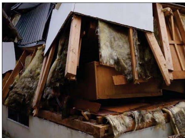
【在来工法】 柱、梁の割れ、断面欠損が著しい。
