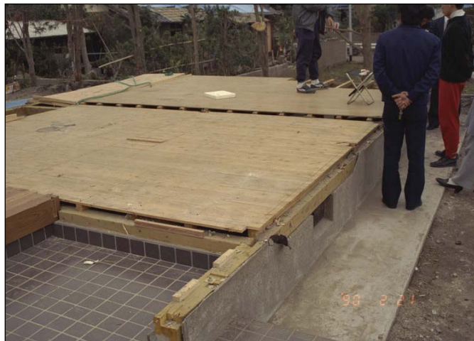
屋根や外壁、床が吹き飛ばされ、床下地、土台などが残る。基礎に被害は見られない。 30005
