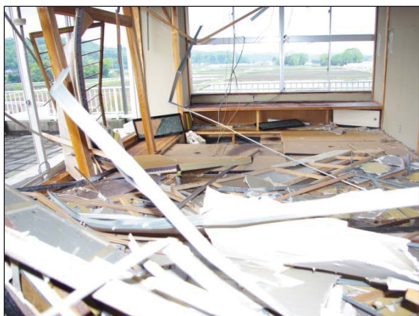
【アルミサッシ、木製サッシ】 枠ごとはずれて破壊されている。
