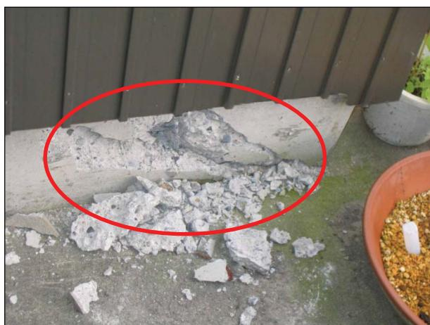
**●破断Ⅲ** 布基礎の割れをさす。
