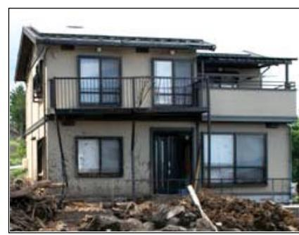
(ベランダ：手摺が破損している。)
