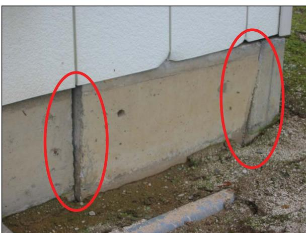
**●不陸** 不同沈下等により布基礎の沈下又は傾斜が生じた場合、その部分の全基礎長さを損傷基礎長とする。
