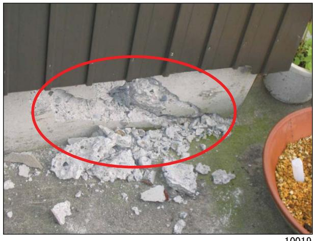
**●破断Ⅲ** 布基礎の割れをさす。**●不陸** 不同沈下等により布基礎の沈下又は傾斜が生じた場合、その部分の全基礎長さを損傷基礎長とする。
